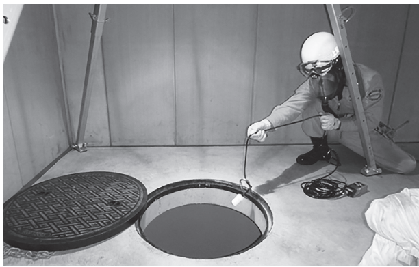
写真8 マンホールや立坑などで測定する際はゆっくり垂下して空間全体を測定します
