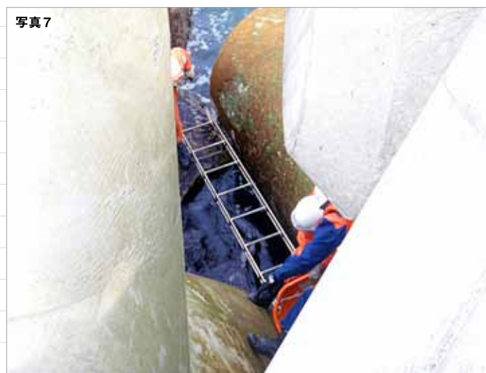
カギ付きはしごをテトラポットの間に敷くことでレール代わりにする。
