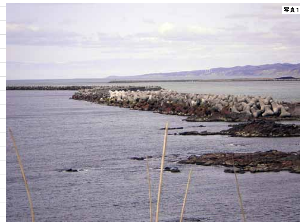
現場となった防波堤。
