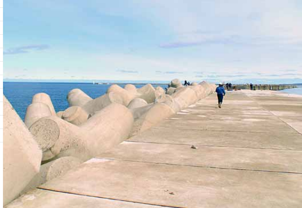
写真2 車両が部署できる位置と災害発生現場が離れているため、現場まで歩いて向かう。
